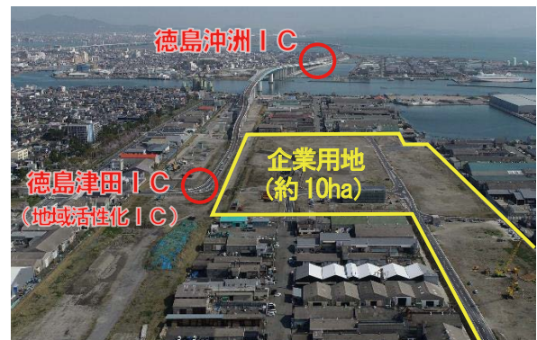
写真－1 徳島小松島港 津田地区活性化整備事業
