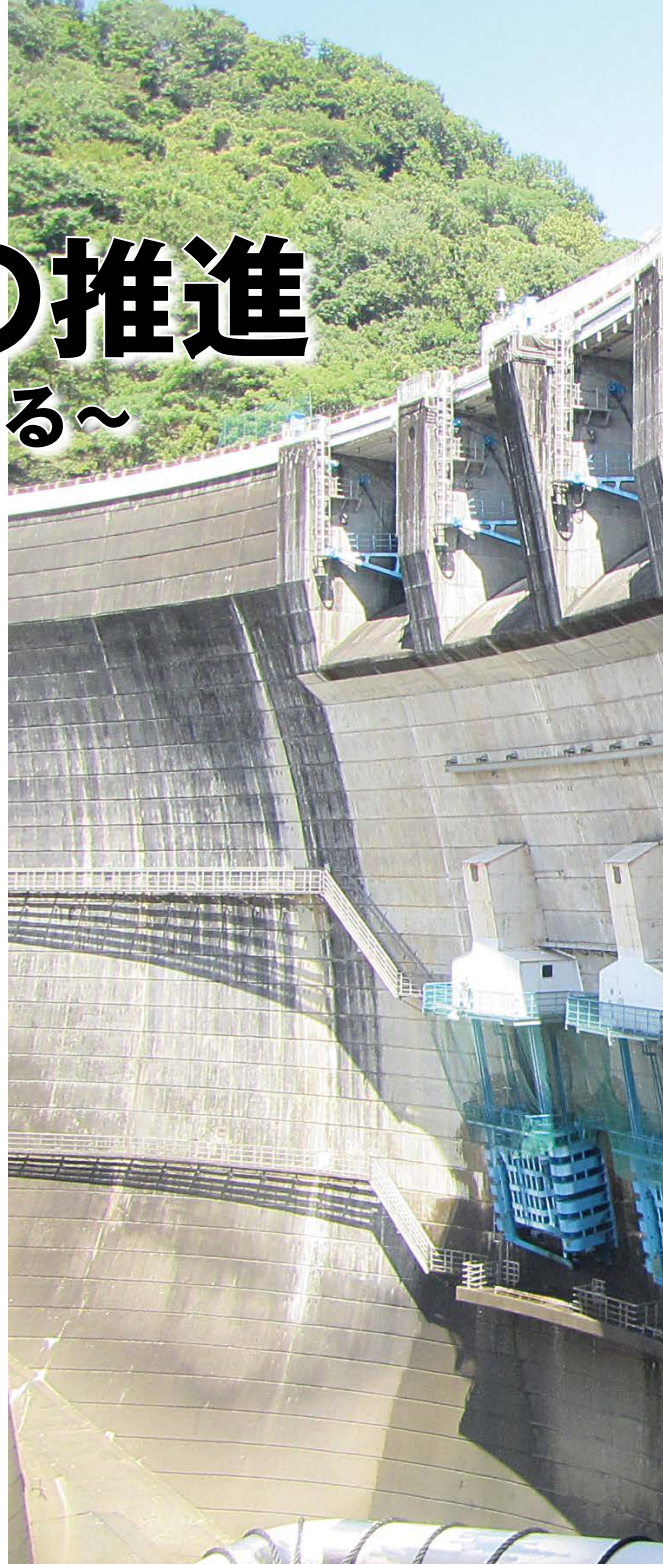
天ヶ瀬ダム管理用通路（キャットウォーク）を歩き、ダム中の設備を見学（本号P8～11「インフラツーリズムによる地域活性化の取組」より）
