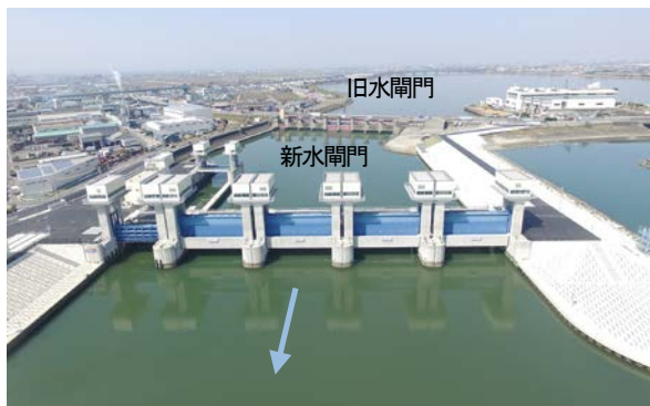
日光川水閘門
