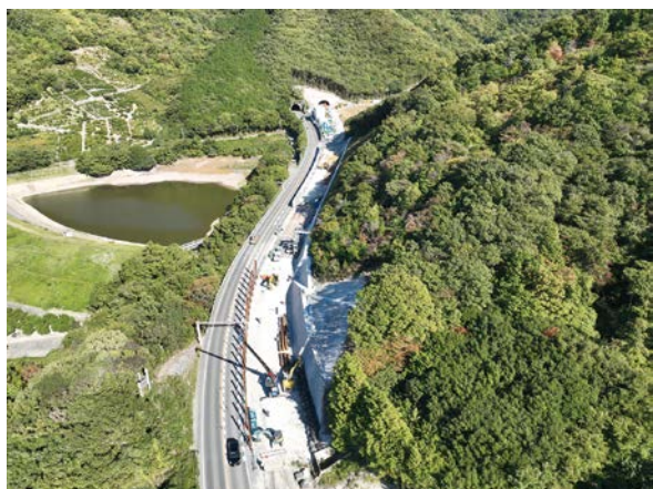
写真-2 さぬき浜街道の整備
