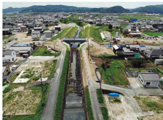
写真-2 高馬川の施工状況
