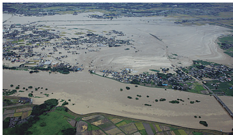
写真-1 上三坂地先破堤地点の状況(写真出典：関東地方整備局)
