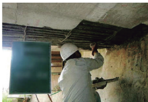
断面修復工事（左官工法）
