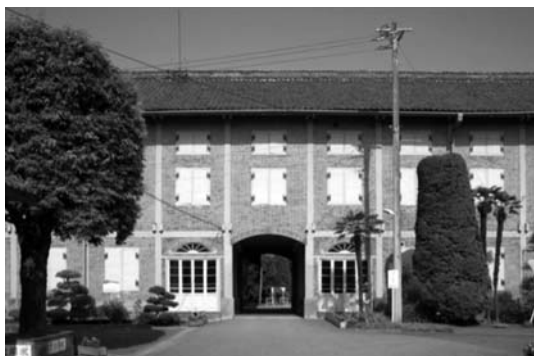
富岡製糸場 東繭倉庫
