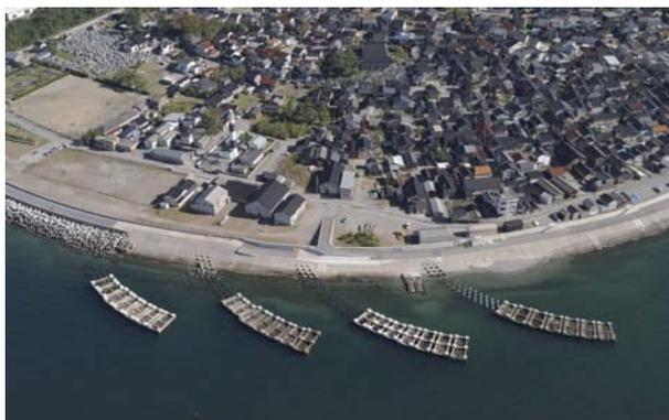
㉒下新川海岸災害復旧等高波対策事業（生地鼻透過型有脚式突堤）
