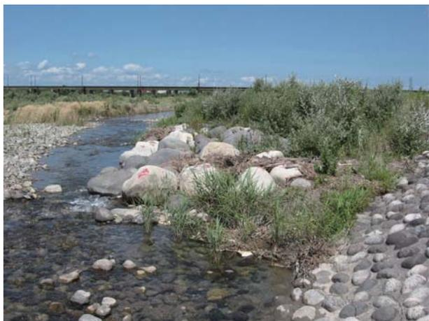
㉑巨石を用いた急流河川対策工法の開発
