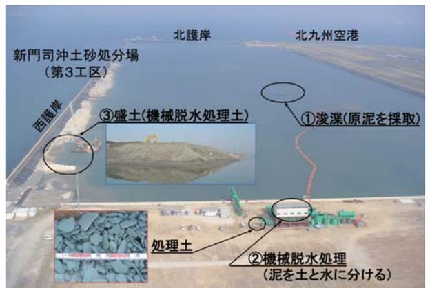
⑤8 構造物としての機械脱水処理土活用技術に関する試験施工
