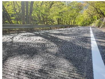
図-1 施工完了状況
