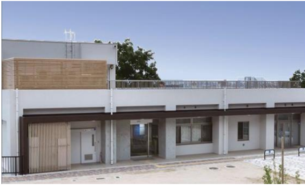
【広島市豪雨災害伝承館(外観)】
