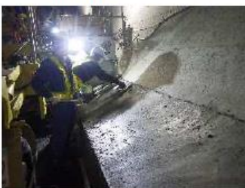
写真-4 生コン打設状況
