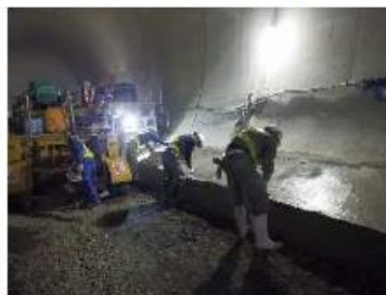
写真-5 表面仕上げ状況
