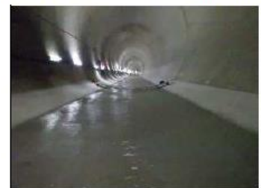
写真-6 打設完了
