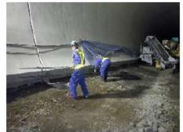
写真-3 チェアー・タイバー設置状況
