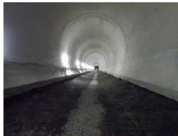
写真-2 掘削・床付け状況
