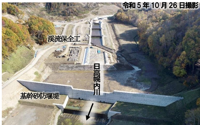
砂防堰堤(完成)と溪流保全工(施工中)
