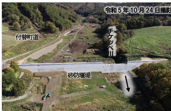
砂防堰堤(完成)と付替町道(施工中)
