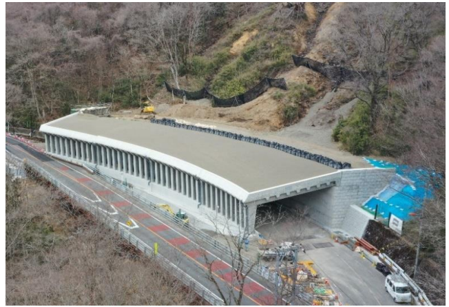
【洞門完成(手前側 仮設橋りょう)】
