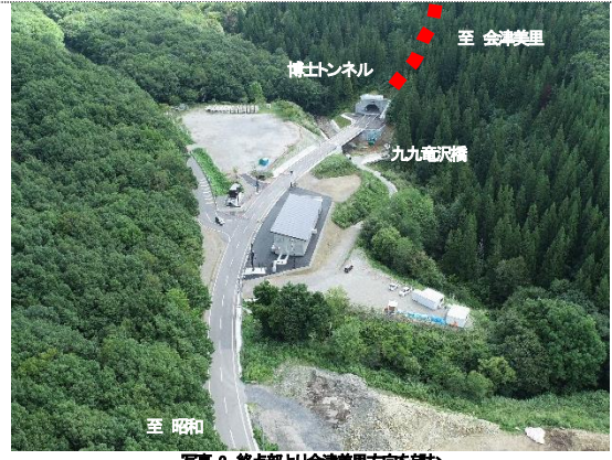
写真2 終点部より会津美里方向を望む
