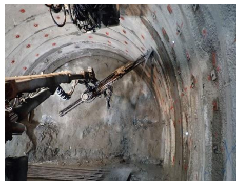
写真3 増ロックボルト打設
