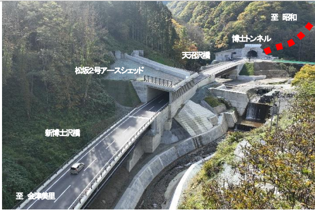
写真1 博士トンネル会津美里町側入口
