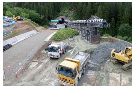
写真4 ベルトコンベアによるズリ運搬
