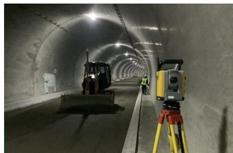
写真5 ICT施工状況
