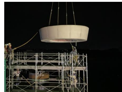
図 - 6 橋脚プレキャスト据付状況
