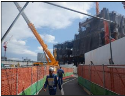
写真4 輻輳している工事ヤード内の歩行者通路の状況
