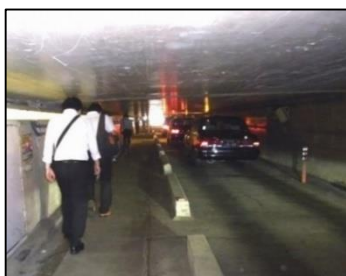
写真2 お化けトンネル(整備前)
