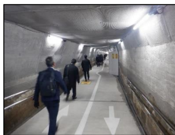
写真3 高輪放水渠内歩行者通路(切替後)
