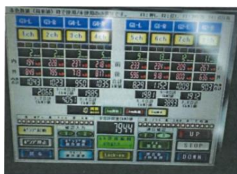
ジャッキの制御状況
