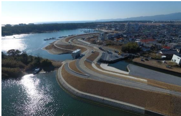
堤防背面の緩傾斜法面や干潟の再生状況、堤防の優美な曲線が見て取れる。
