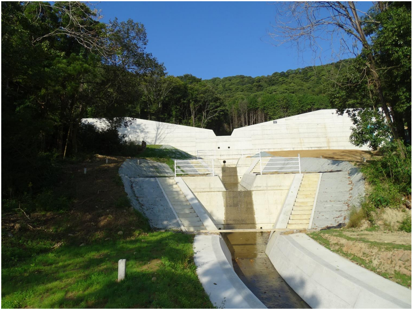
砂防堰堤完成時
