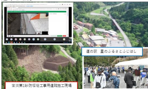
室洞第1砂防堰堤工事用道路工事現場
