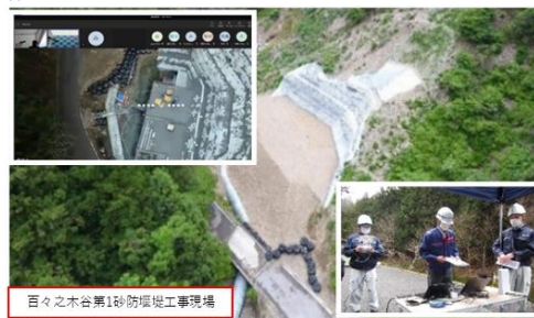
百々之木谷第1砂防堰堤工事現場
