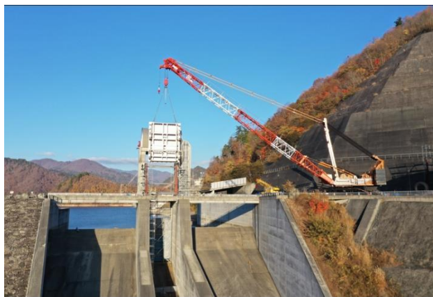
大型クレーン(650t吊)によるゲート扉体の吊り込み 【奈良俣ダム】
