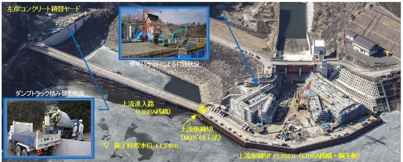
貯水池内における施工設備の状況
