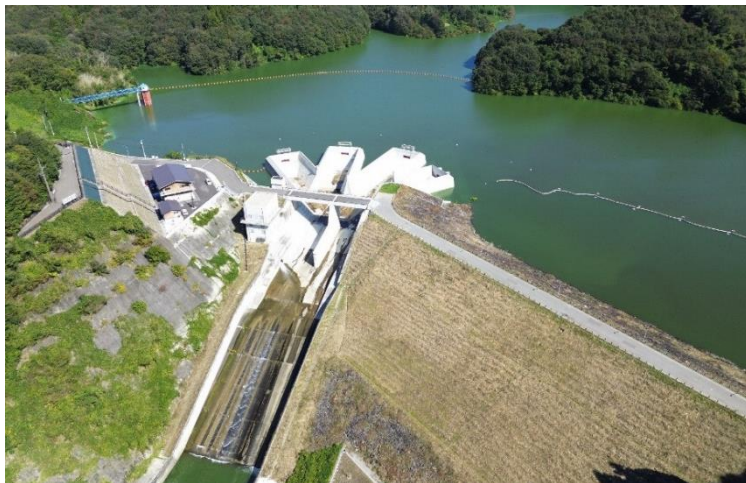
【試験湛水中の千五沢ダム(令和5年11月8日現在)】
