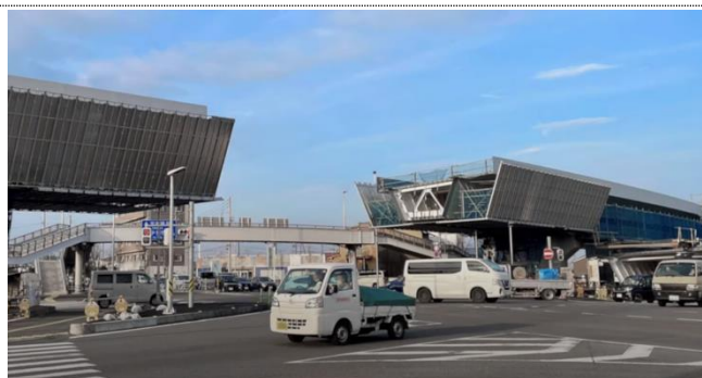
【現地状況(架設前)】
