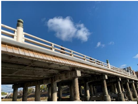
再生した木製高欄と桁隠し(天正期のものとされる擬宝珠は再利用)
