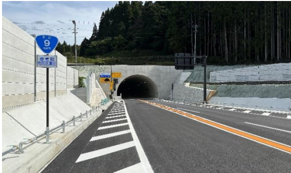
笠波トンネル起点側坑口
