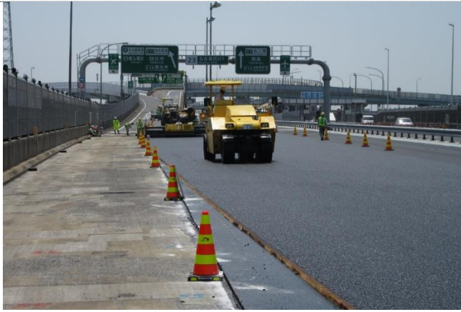
昼夜連続・通行止め方式による施工状況
