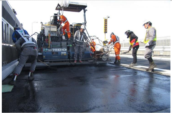
高性能床版防水工の施工状況
