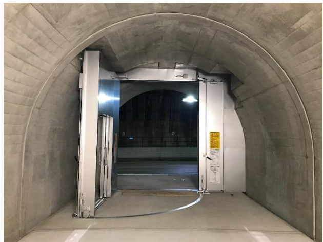
▲各務原トンネル避難連絡坑(避難連絡坑から本線)
