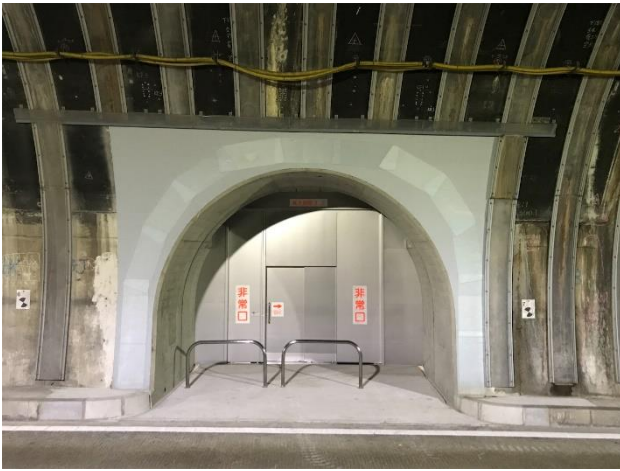
▲各務原トンネル避難連絡坑(本線から避難連絡坑)
