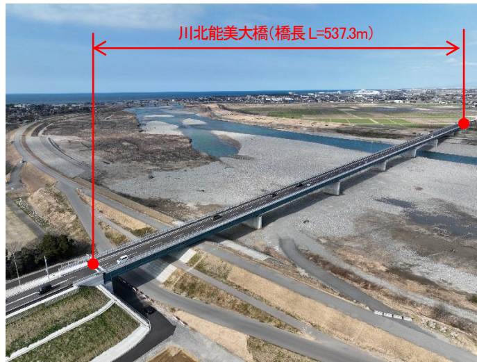
完成写真「川北能美大橋」
