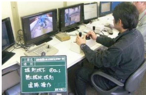
▲ケーソンショベルの遠隔操作状況
