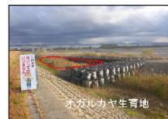
オガルカヤ生育地の仮締切堤設置状況 (令和2年11月30日)
