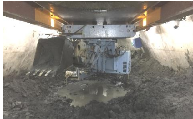
▲ケーソンショベルの無人掘削作業
