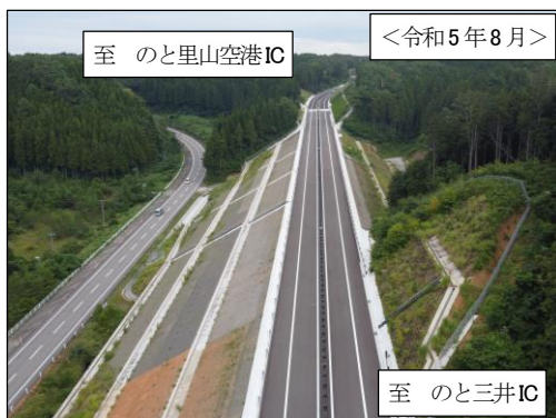
【ICT 施工、積極的なデジタル技術施工技術を用いて施工した開通前の状況】
