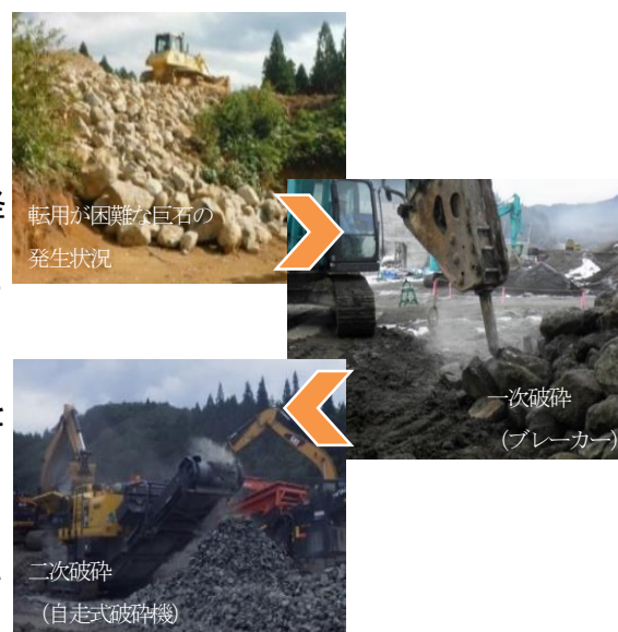
【巨石の破碎処理の流れ】
