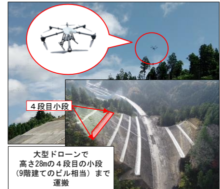
【大型ドローンによる資材運搬】
