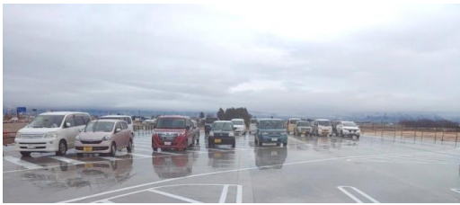
写真-⑧ 駐車場消雪パイプ設置状況
