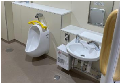
写真一④ 子供用トイレ
