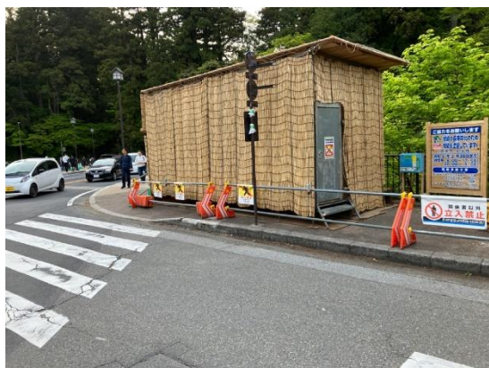
【現場環 境改善】 塗装実施 中の仮設 設備(クリ ーナルーム)
