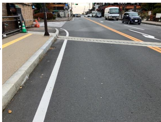
【補修後】 終点側 下り線の 橋面状況 (車道: As 舗装、歩 道: 滑り止 め舗装及 び点字ブ ロック)
