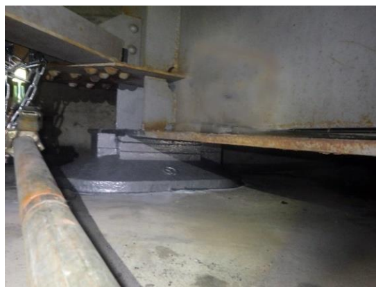
【補修後】 支承部 防錆工
