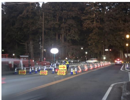
【通行規制】 片側通行 規制状況
