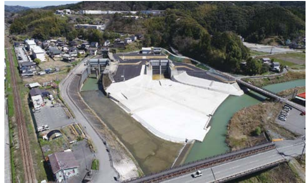
完成した新日下川放水路（呑口部）
