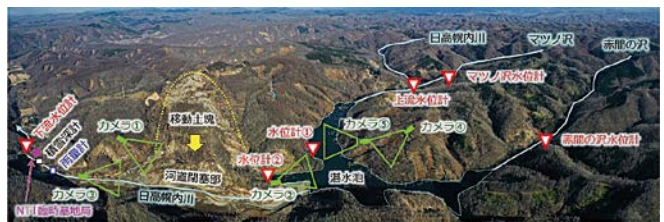
監視観測設備機器整備
