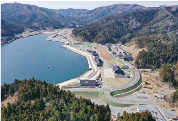
雄勝防潮堤と背後のまち並み
