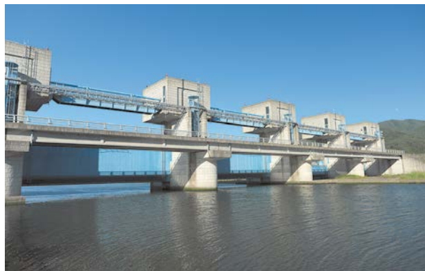
自動閉鎖施設の一例（宮古市 津軽石川水門）
