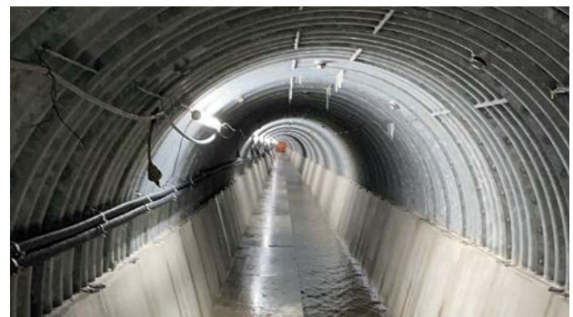
排水トンネル内部
