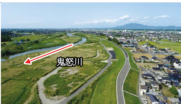
事業により整備された鬼怒川の堤防
