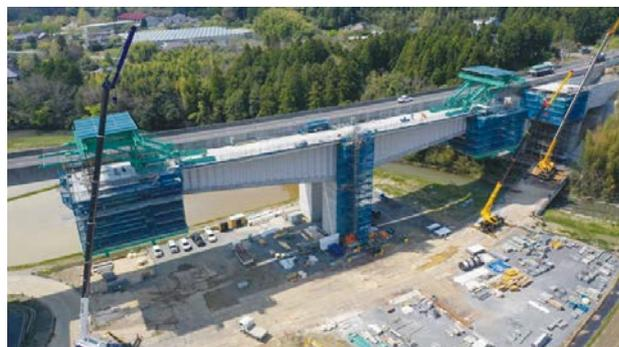
大型移動作業車による張出施工
