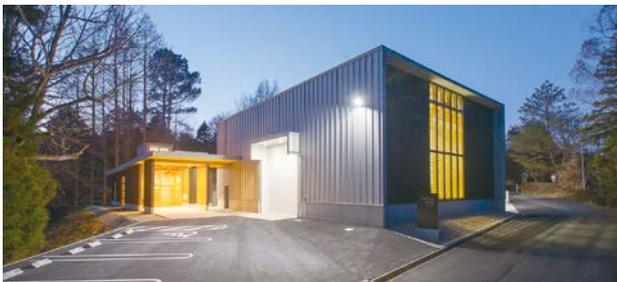
木造軸組工法とCLTパネル工法で整備した林業技術研修棟
