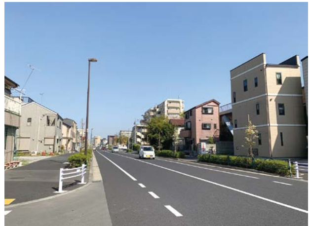
交通開放区間の状況
