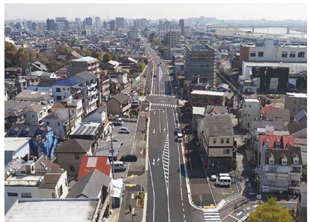
関原工区上空から東側を望む
