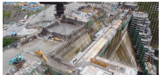
減勢工の施工状況
