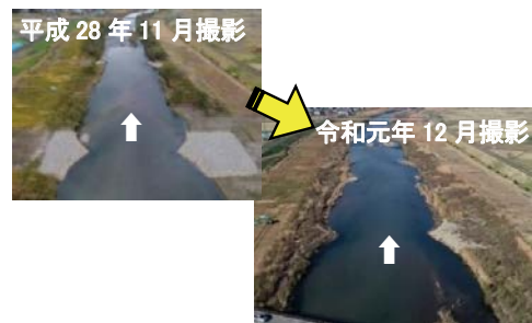
施工後の様子
