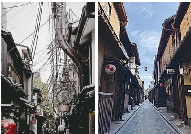
整備前の電線類の状況（左）と整備後の先斗町通（右）
