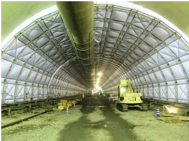
養生バルーン設置状況
