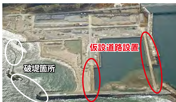
鵜ノ尾岬地区復旧中の状況
