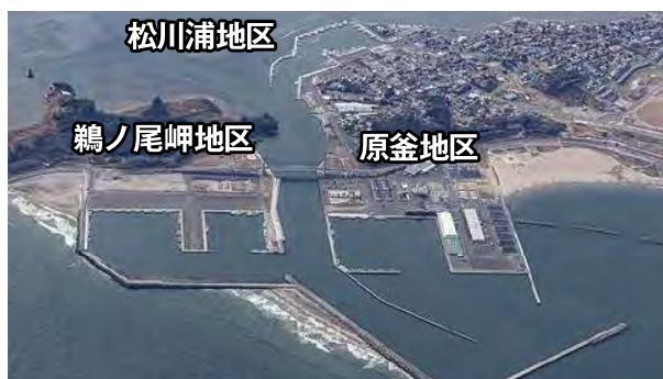
復旧後の松川浦漁港全景
