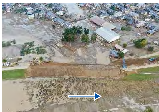
応急仮堤防完成（令和元年10月17日）
