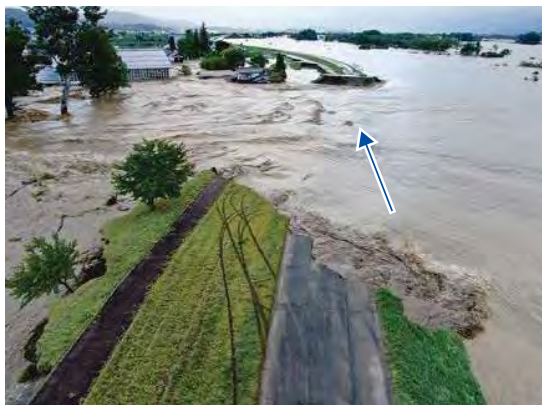
堤防決壊状況（令和元年10月13日）
