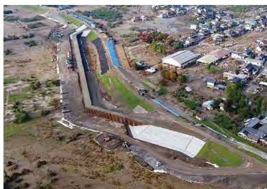
鋼矢板二重締切堤防完成（令和元年10月30日）
