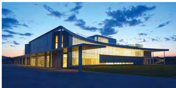
施設全景 南東側より
