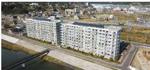
早期に建設された災害公営住宅（南気仙沼地区内の脇住宅）
