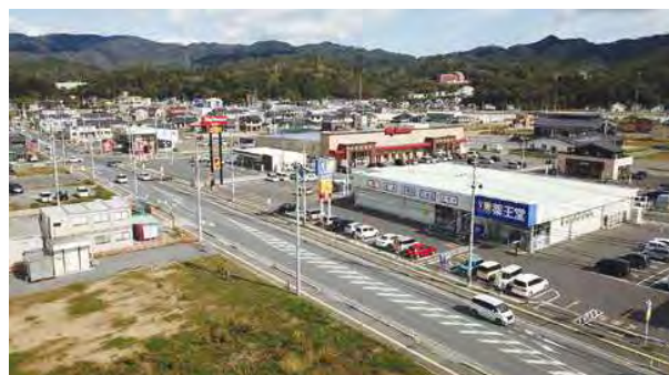
幹線道路沿いに立地した商業施設（鹿折地区）
